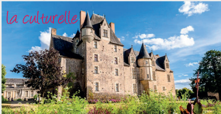
CHÂTEAU de BAUGÉ
