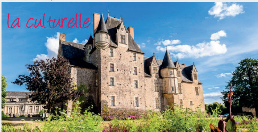
CHÂTEAU DE BAUGÉ
