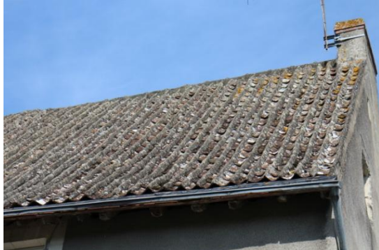
Pose à l'ancienne de tuile baugeoise et coupe sur une tuile baugeoise.
