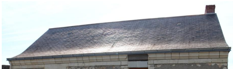
Toiture à 2 pans avec ligne de coyau
