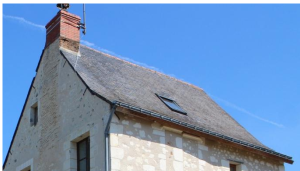
Le velux s'insère discrètement dans la pente de la toiture
